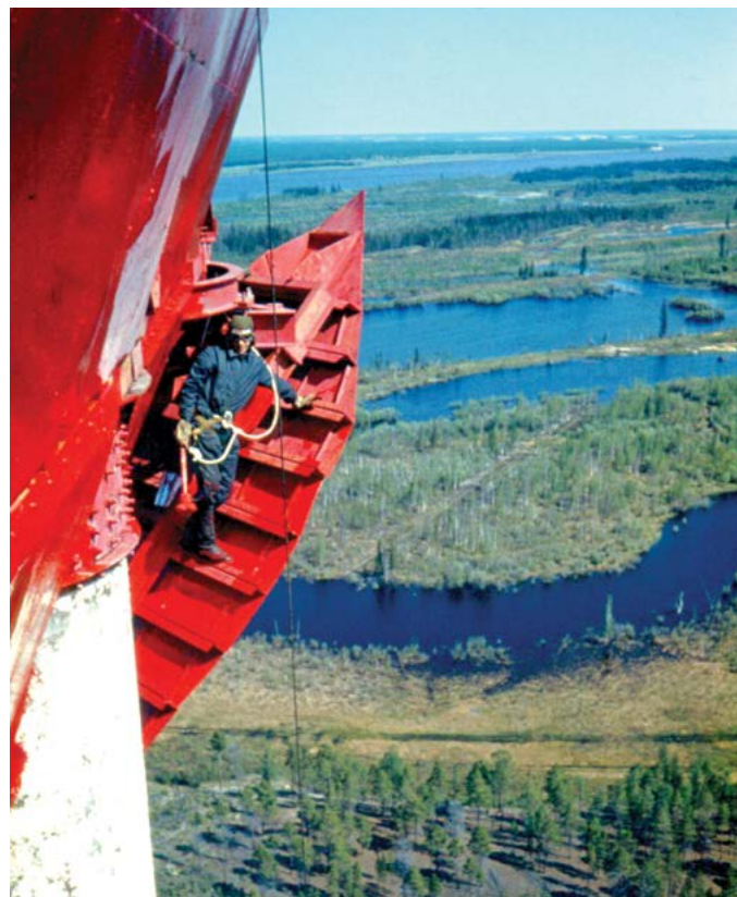
● Покраска мачты линии связи. Якутия, 1986.
