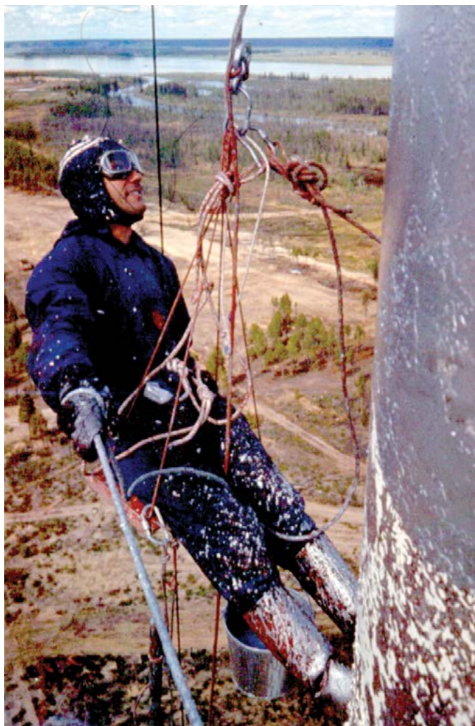
● Покраска ствола мачты. Якутия, 1986.
